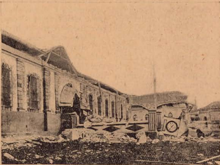
El cuartel militar. El ático cayó por completo arrastrando la torrecilla donde estaba el reloj.
