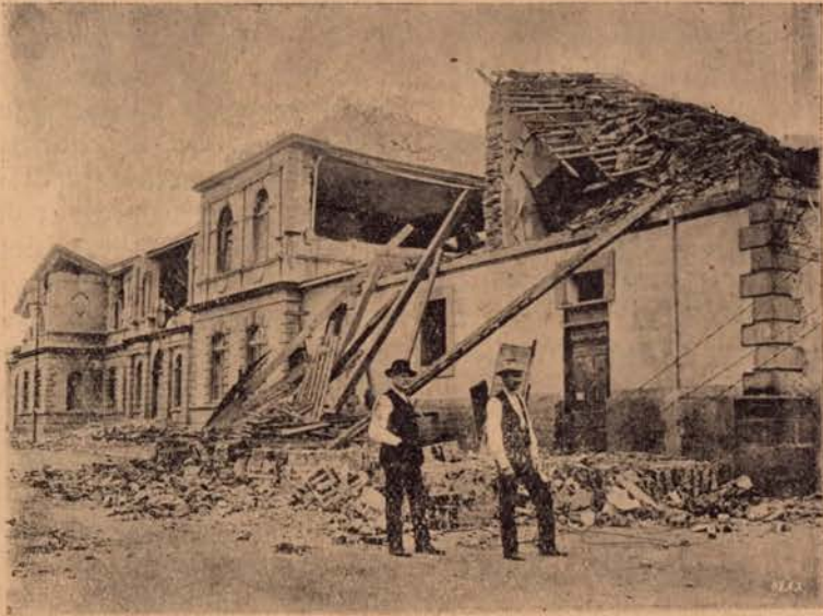
Las Escuelas Públicas y el Salón de Teatro quedaron completamente destruidas.
